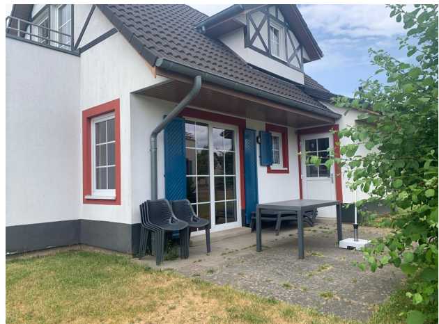
Terrasse Haus Nr. 611
