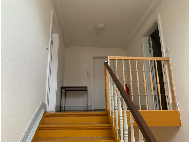
Treppenaufstieg zur Büroeinheit im Dachgeschoss
