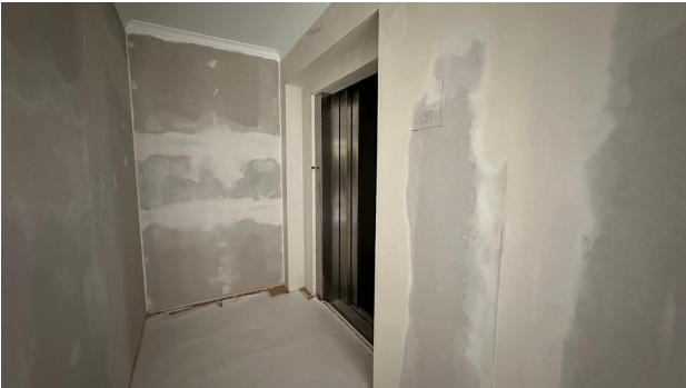
Aufzug im Hausflur
