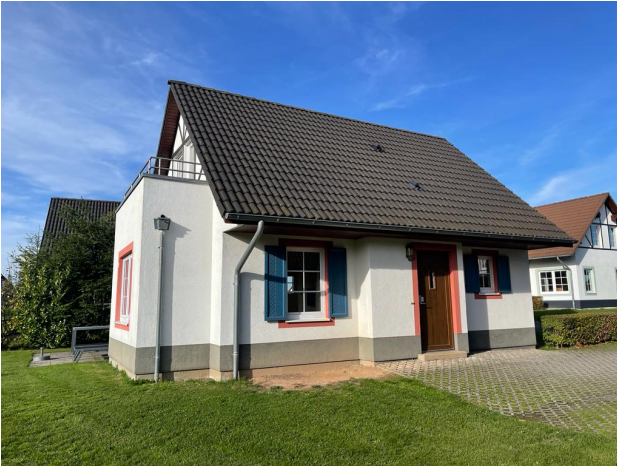
Ansicht von Außen
