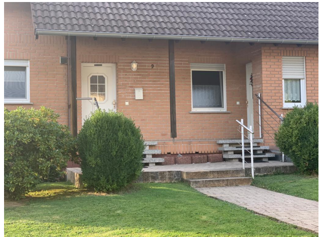
Außen - Eingangsbereich - Zwei Eingänge
