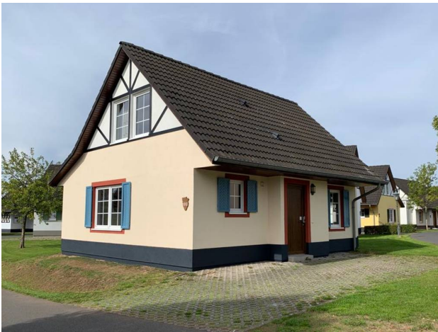
Außen mit neuem Anstrich
